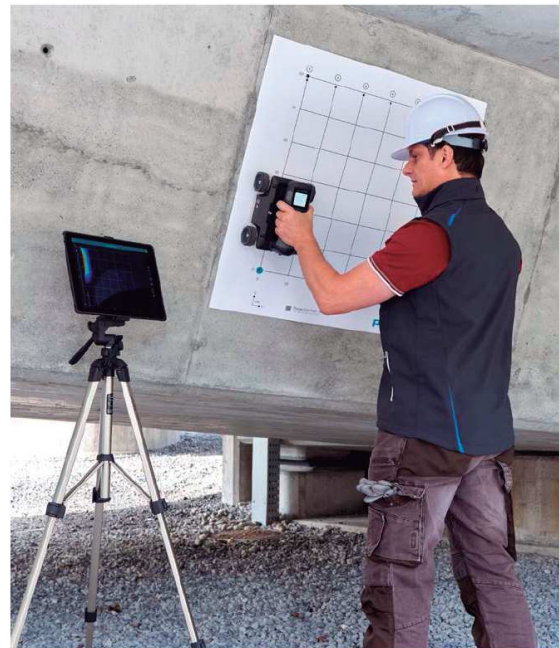
GPR LIVE trabalhando no modo de medição Line Scan
